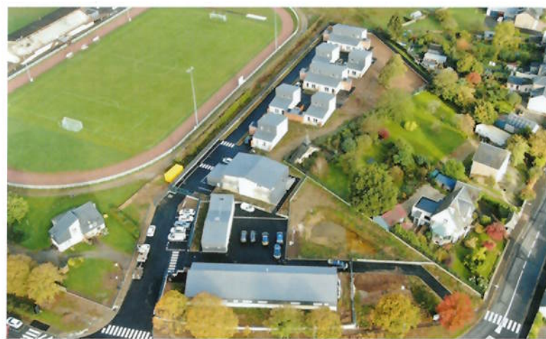
À La Ferté-Macé, Orne Habitat a construit une gendarmerie sur le terrain de l'ancien camping municipal. © Gendarmerie 61
