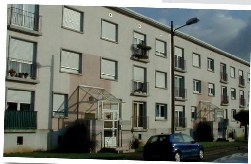
Hagondange rue Charles-Lutz Avant réhabilitation
